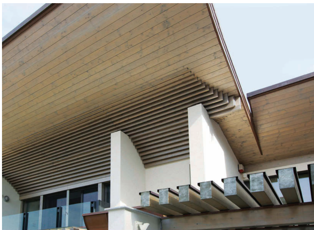
Sopra, il tetto è ventilato, con un isolamento termico in fibra di legno; la finitura interna è con travi a vista.
