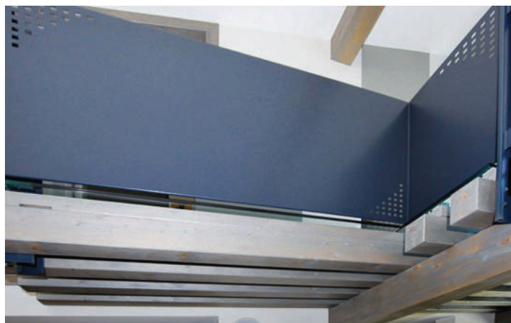
Sopra , i dettagli a vista rendono chiara la lettura della rete strutturale, definita dalla successione di soluzioni tecnologiche in legno.
