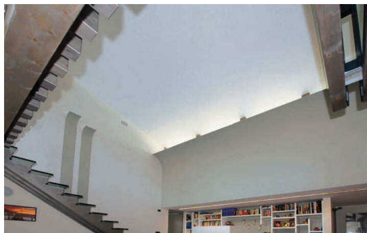
Sotto , il solaio è realizzato applicando la struttura Xlam nello spessore di 120 mm, con finitura in cartongesso ( www.kager.it ).
