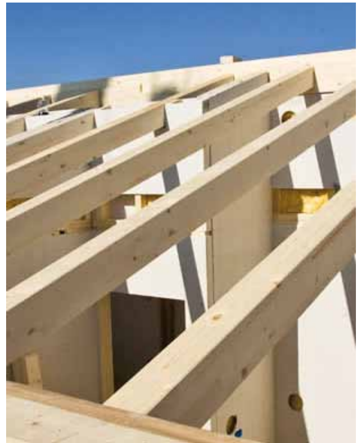
Fase iniziale di montaggio di un tetto.
